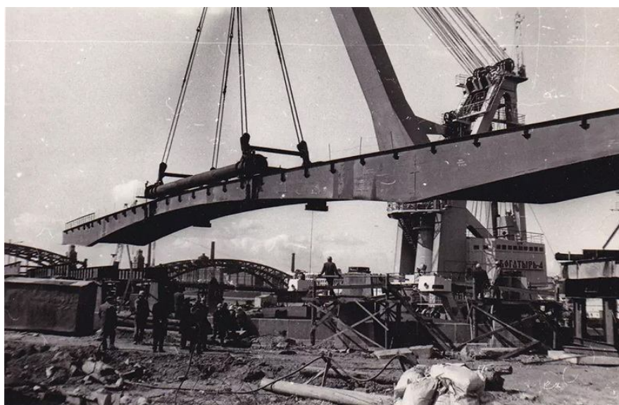
Строительство Малоохтинского моста (с расширением набережной). Фото 1984
